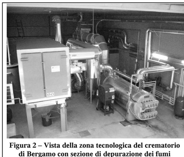
Figura 2 – Vista della zona tecnologica del crematorio di Bergamo con sezione di depurazione dei fumi
